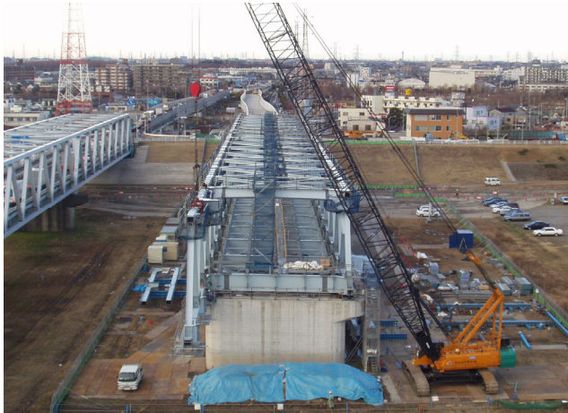
クローラークレーンベント工法
