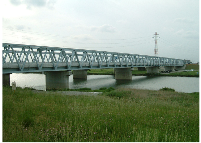
左岸側(千葉方)より右岸側(東京方)を望む
