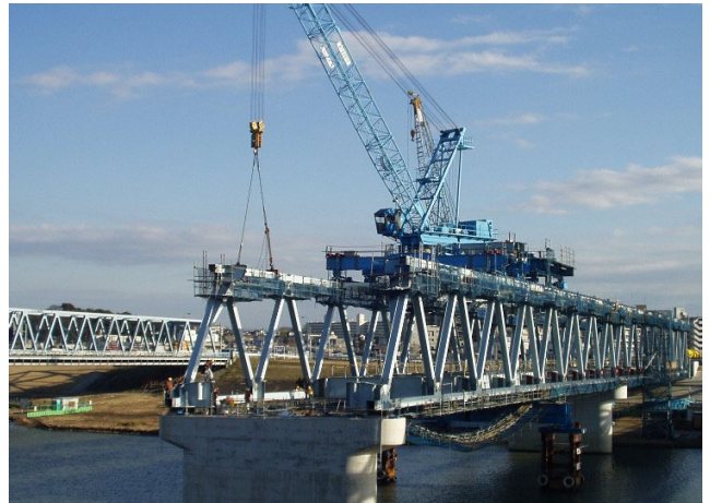
トラベラークレーンベント工法
