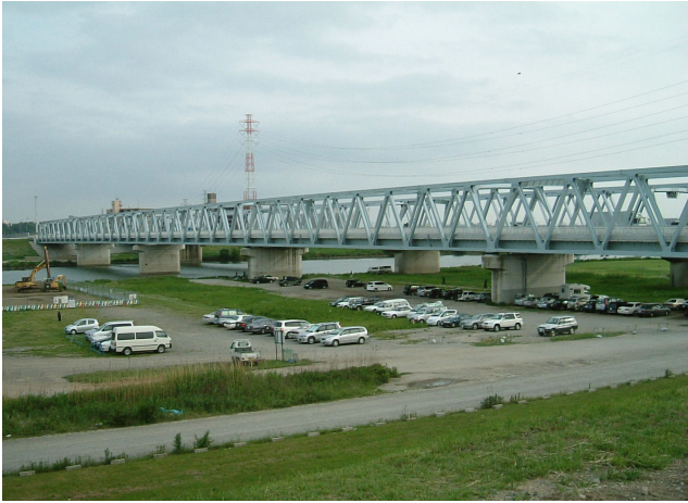
右岸側(東京方)より左岸側(千葉方)を望む
