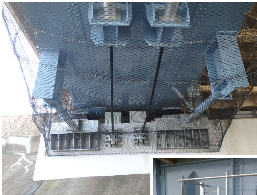
A Y 1 橋台 (G2 側)
