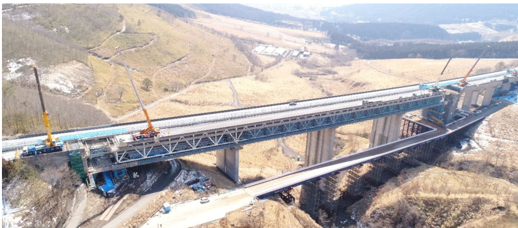
鋼桁取替状況
