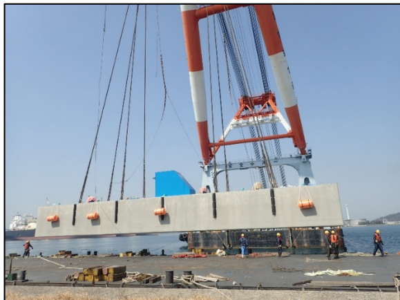
浮体進水状況
