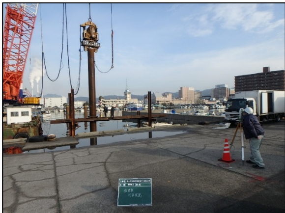
杭打ち状況（ハイブロンマ）
