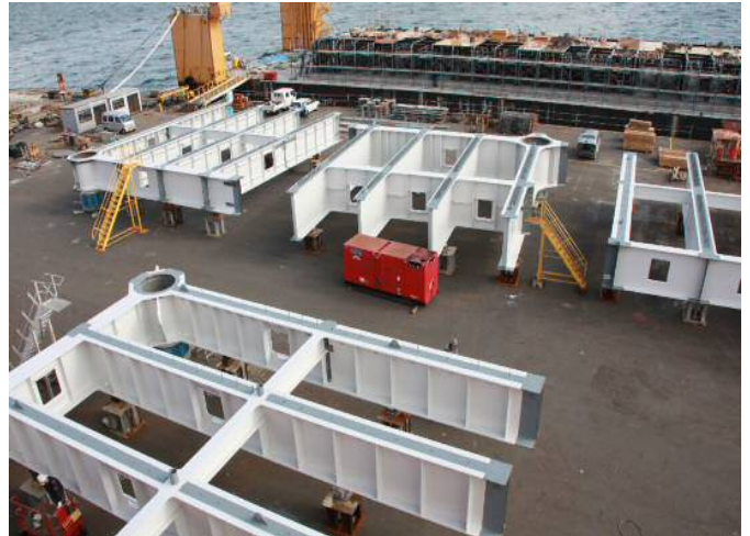
ブロック製作状況
