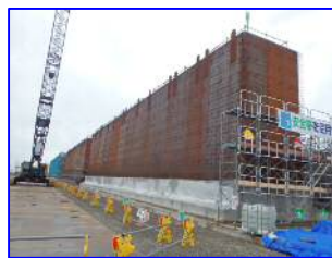
コンクリート打設
