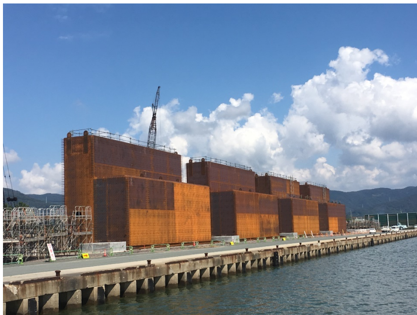
鋼殻据付完了
