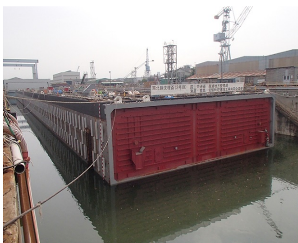
2号函鋼殻出渠時
