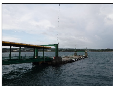
既設上屋撤去後
