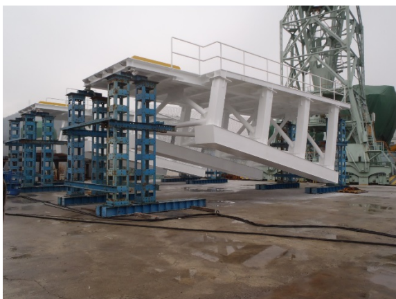
工場製作完了
